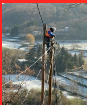
■ Pose de câble basse tension sur un terrain inaccessible. Le Poët-Célard
