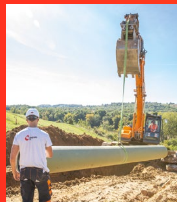
■ Travaux d'irrigation. Chatte et Saint-Bonnet de Chavagne
