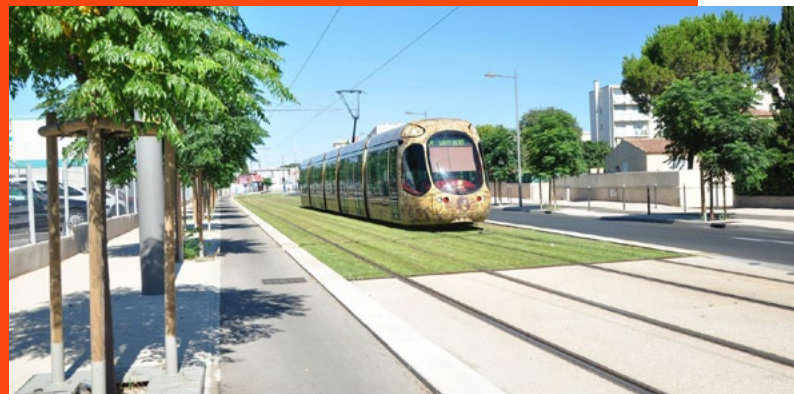
■ Aménagements bétons. Tramway de Montpellier.
