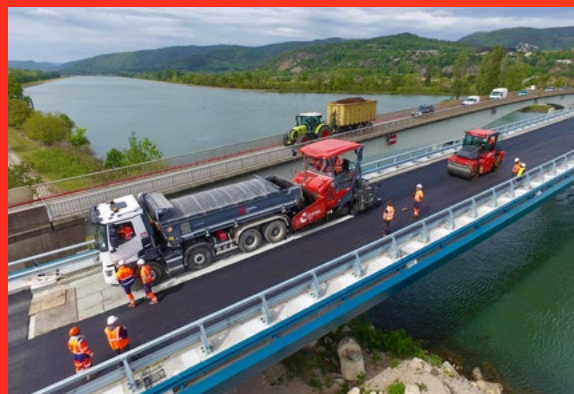
■ Réalisation de bordures et de revêtement en enrobés. Charmes-sur-Rhône
