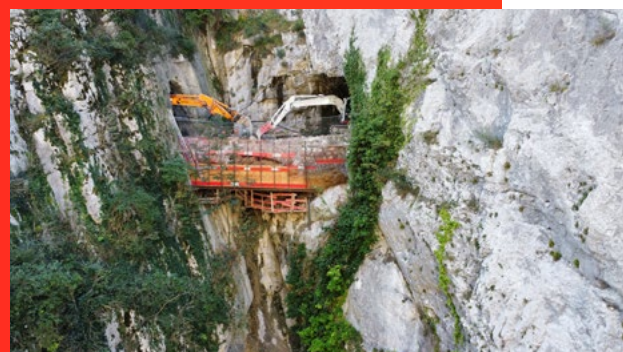
■ Déconstruction du pont entre deux tunnels des Petits Goulets. Vercors
