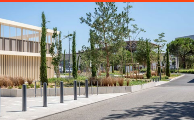
■ Aménagements urbains et végétalisés. Palais des Congrès Jacques Chirac. Valence.
