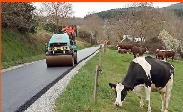
Le fraisat est un matériau issu du rabotage de couches de chaussées. Il s'agit de croûte de vieux enrobés grattés. Après avoir subi un traitement complémentaire, le plus souvent un concassage, ce matériau donnant de l'agrégat d'enrobé, il peut être recyclé.
