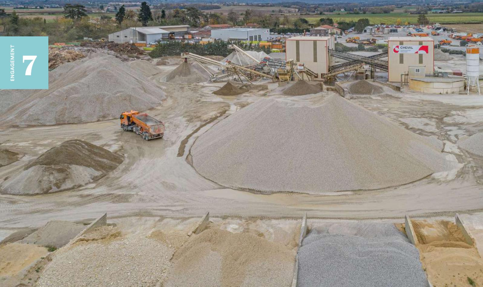
Cheval Granulats possède deux installations de criblage et de concassage traitant annuellement 500 000 tonnes de matériaux, principalement à destination des industries béton et enrobé.
